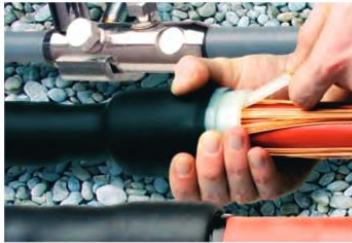
EMPALMES EN FRÍO HASTA 35KV
